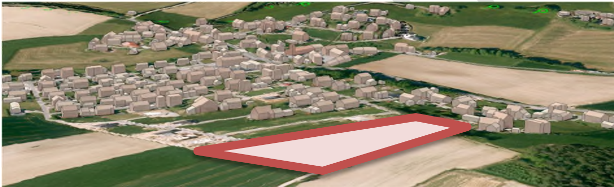
Abb. 9: Schrägluftbild mit Darstellung des Plangebietes (rot) im Anschluss an den Siedlungsbestand von Traitsching; Ansicht von Nordosten, o.M.
